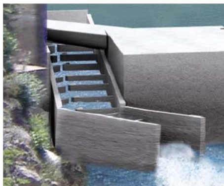
Passé à poissons à bassins successifs (Crédits : photothèque EDF)
