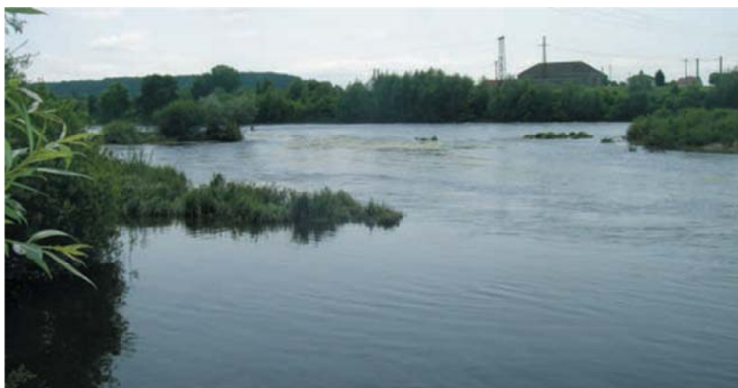
Le barrage de Maisons-Rouges avant et après les travaux d'effacement
