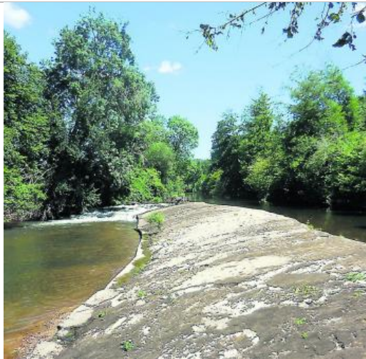
La chaussée du moulin de Merlançon, à Figeac./Photo DDM. A. P.
